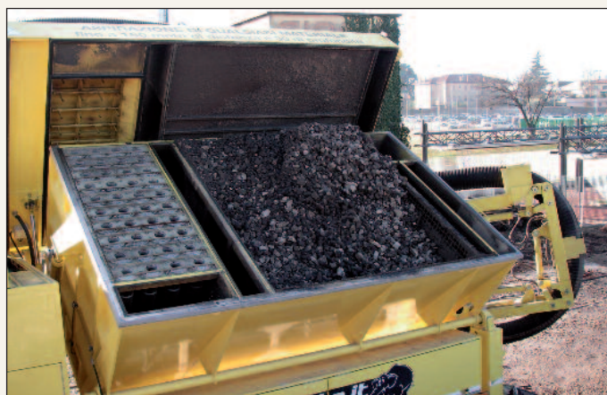
Figura 5 - Un momento dello scarico del ballast
