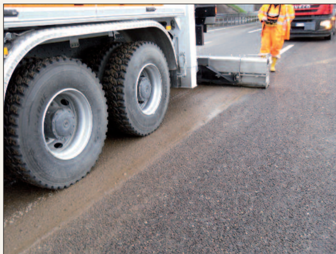
Figura 9 - Un esempio di pulizia dopo un'alluvione
