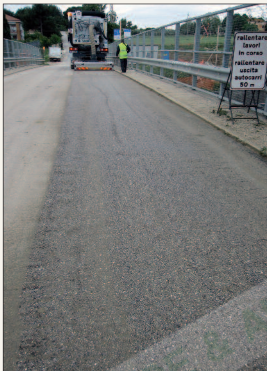
Figura 8 - La fase della pulizia del manto stradale con l'attrezzatura Lavaspyra
