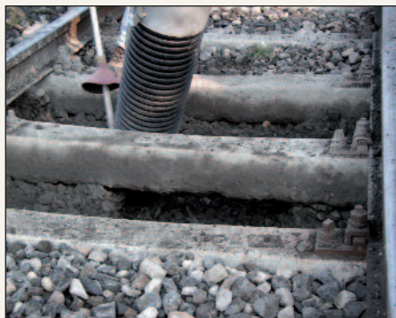
Figura 6 - La fase di aspirazione
