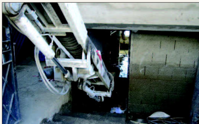
Figura 2 - La pulizia all'interno di un'abitazione con escavatore a risucchio
